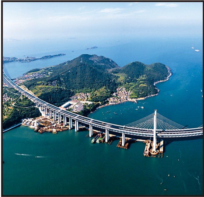
●圖：跨海而建的福建平潭海峽公鐵大橋。\\中新社
